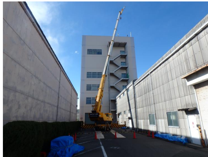
クレーン作業
