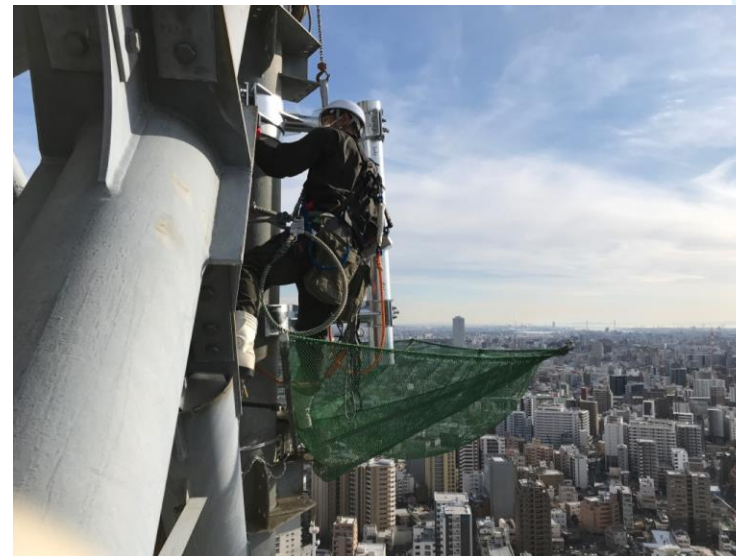
携帯電話アンテナ取付作業
