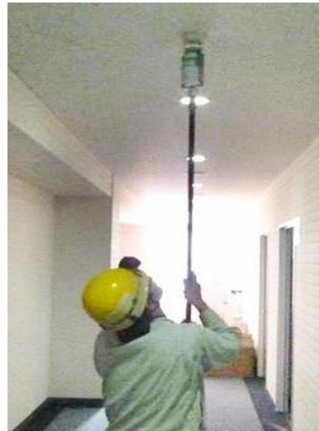
感知器点検作業
