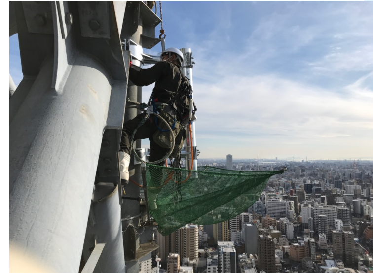
携帯電話アンテナ取付作業
