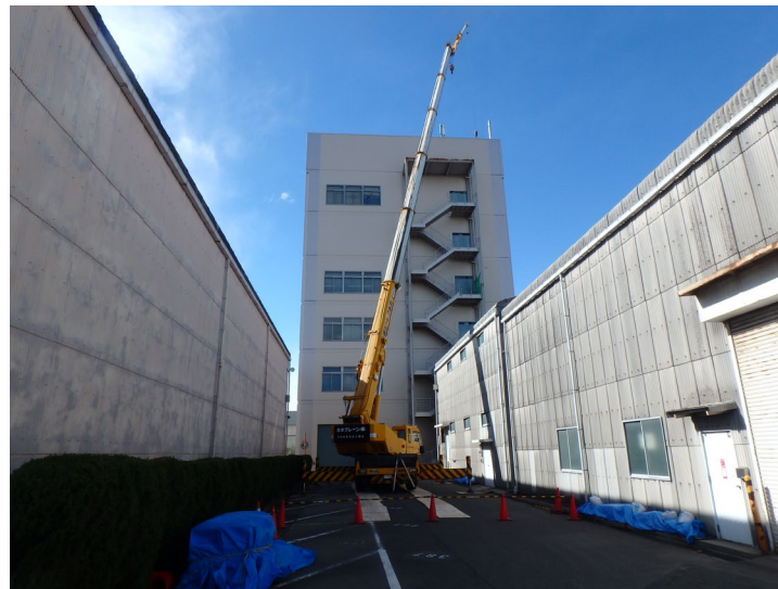
クレーン作業
