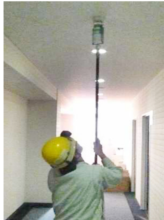
感知器点検作業
